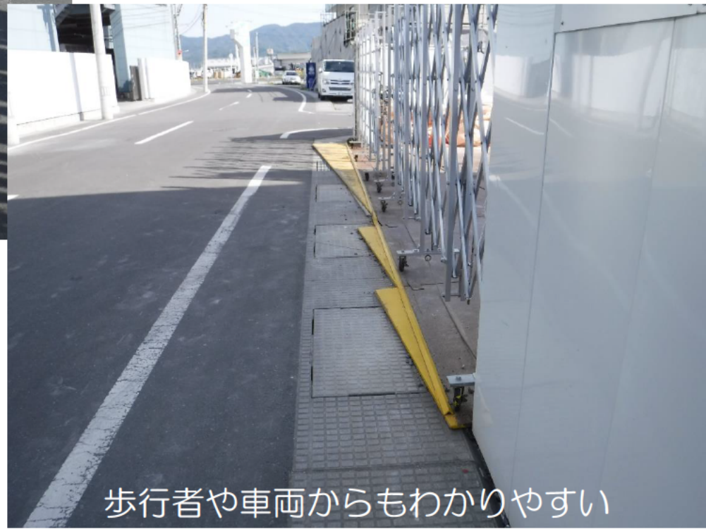
道路占有部敷鉄板の視認性の向上のため、 境界を境に黄色く鉄板を塗装している
