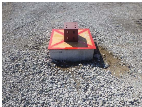
外構部の木板+鋼材による養生
