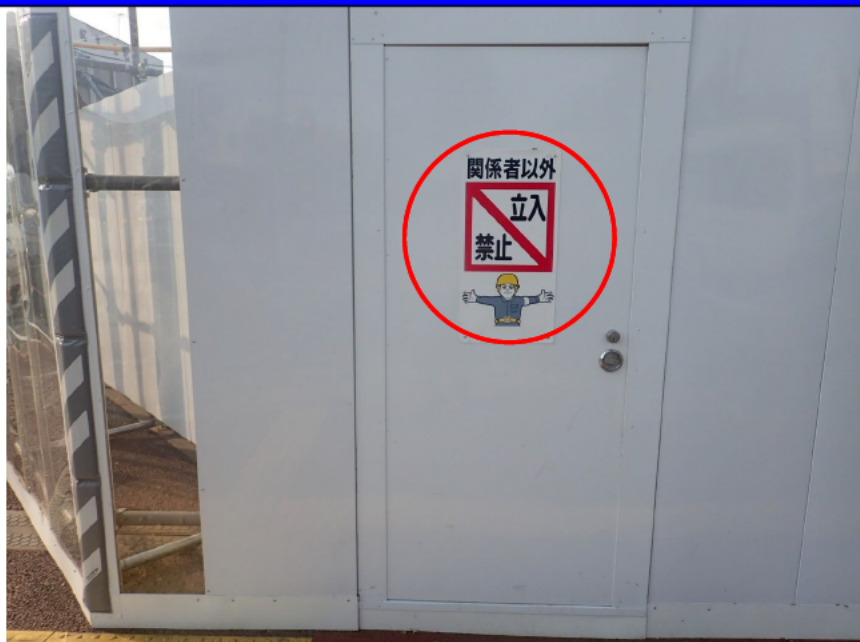
仮囲いくくり戸に第三者立入禁止看板掲示
