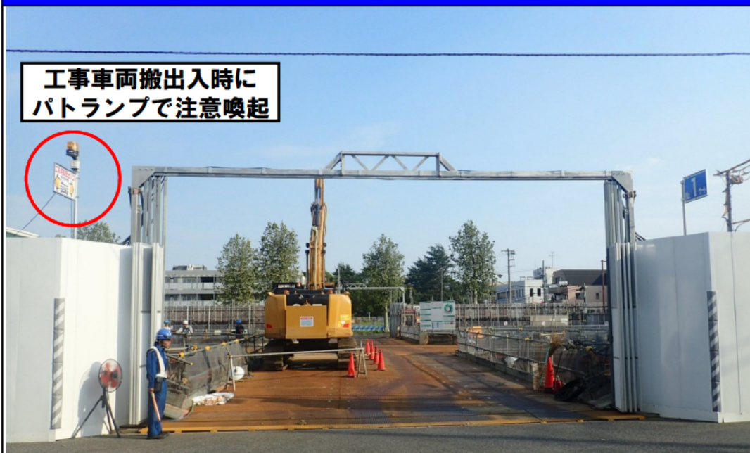
仮設ゲートにパトランプを設置し注意喚起
