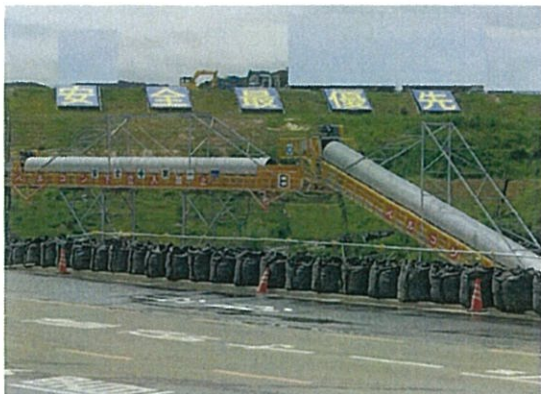
手前ベルトコンベアーの<安全+第一>60cm * 60cmと比較しても約60m先の<安全最優先>4.0m * 5.0mの方がはっきり見えます。
