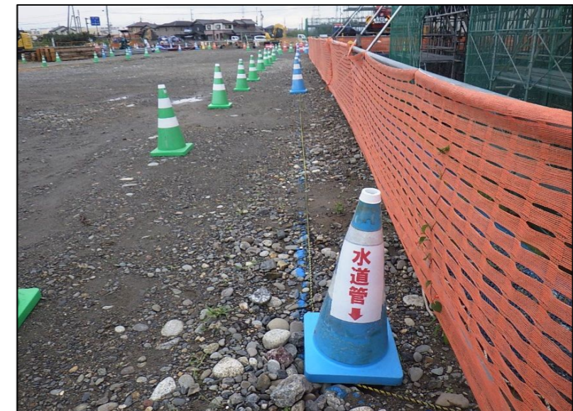
掘削箇所付近に水道管が埋設しているため、カラーコーン(青色)及びトラロープにて明示しました
