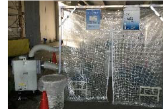
【上階クールハウス設置】
