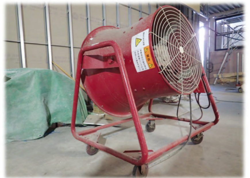
現場内各所に大型送風機を設置
