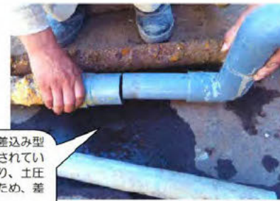
給水管継手状況
