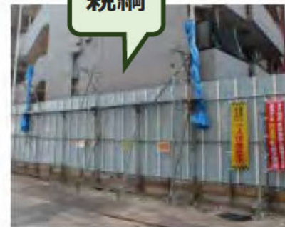
仮囲いを利用した事例
