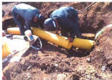
ガス管復旧状況
