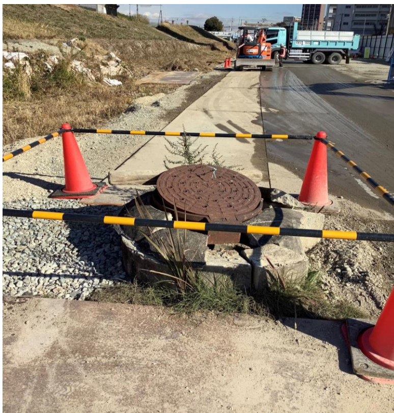
(既設人孔 養生前)
