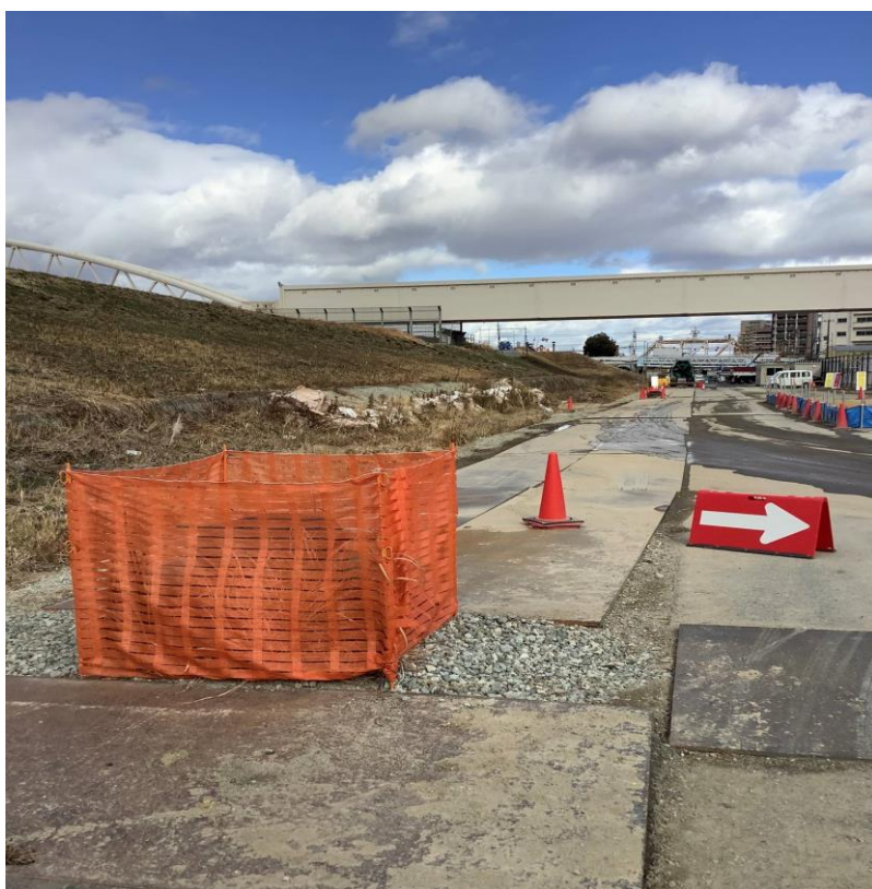
(既設人孔 養生後)
