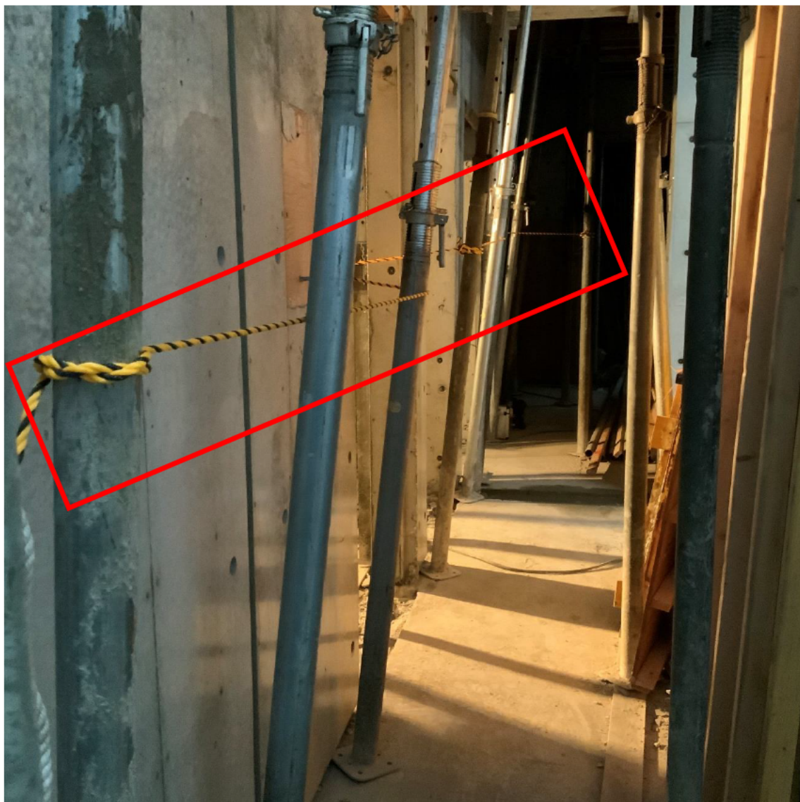
支保工組立中の作業通路見える化
