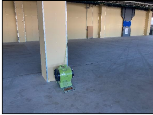
換気用送風機の常設
