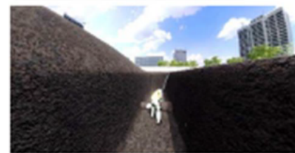
(3). 土砂崩落災害
