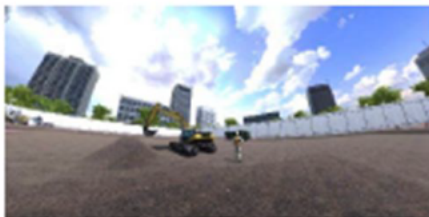
(4). 重機接触災害
