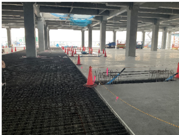
赤:躯体後施工部での転倒防止
