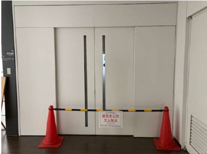
工事エリア表示(既存扉部)
