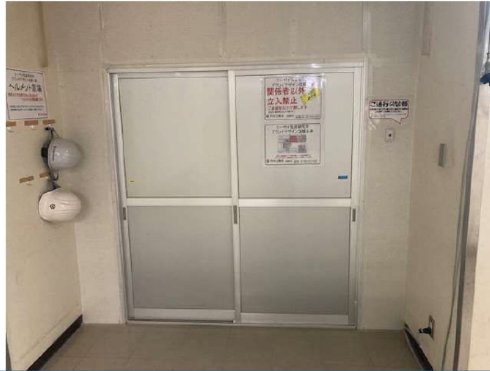
仮設間仕切壁
