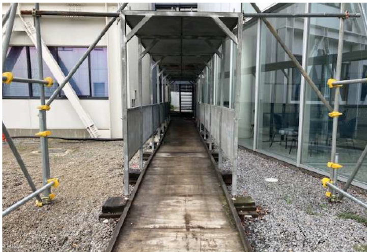
第三者用仮設通路
