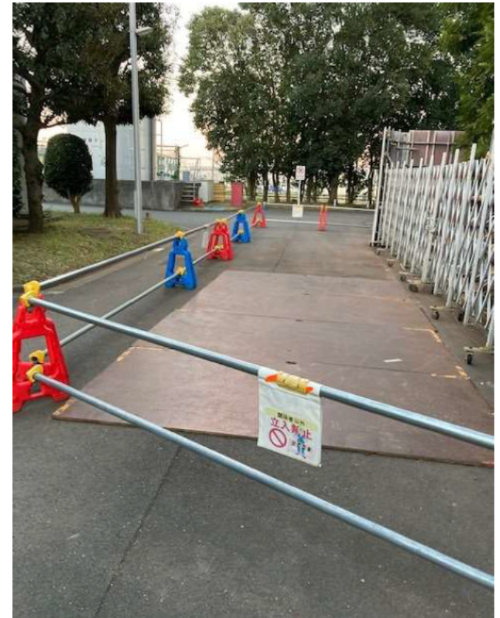
敷地内通路の 工事エリア表示
