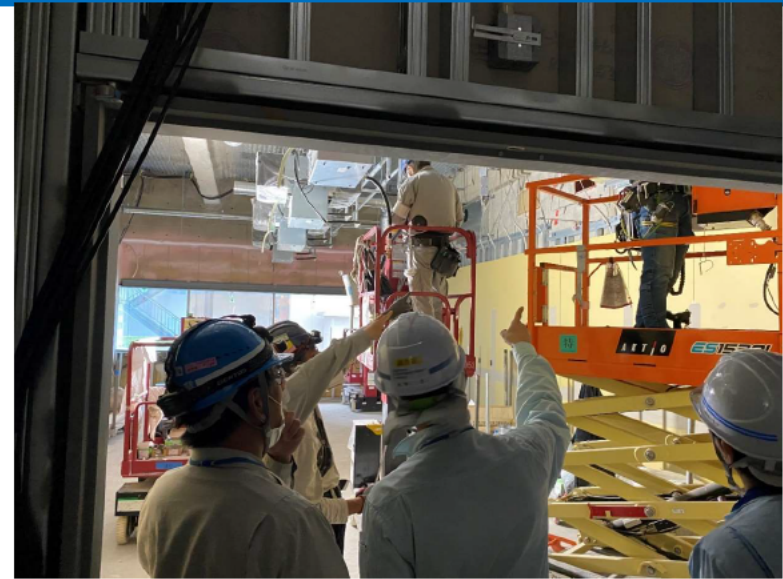
建築・設備合同確認会（毎朝）
