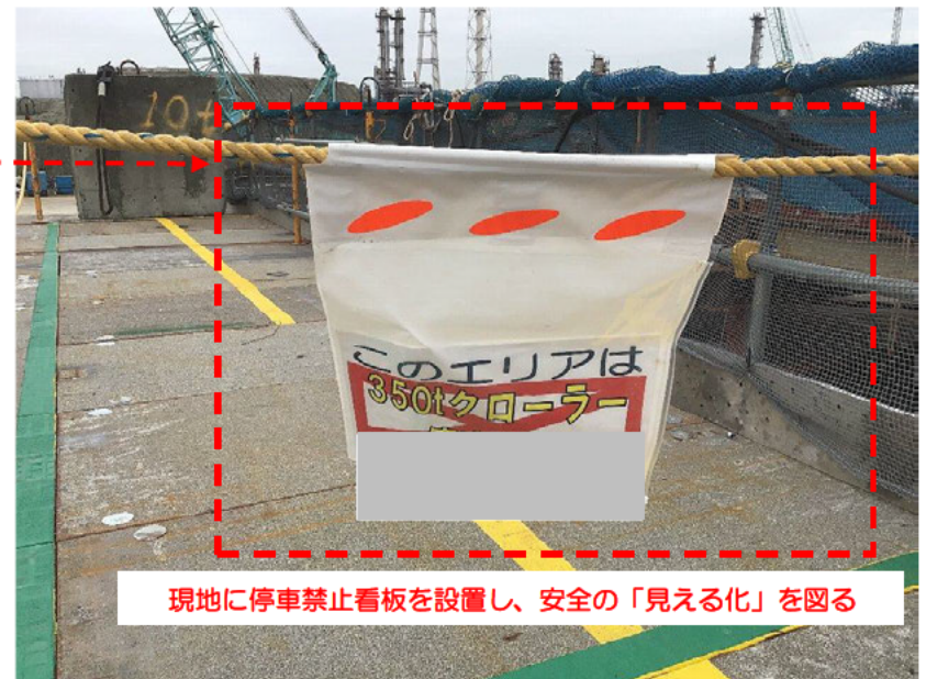
【参考資料】 構台上の重機作業制限エリアの見える化
