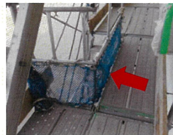
人の墜落対策を手摺と中棧、物の落下を防網を巾木型に取付けた地足場
