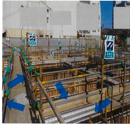
単管手摺中棧と足場板巾木の地足場
