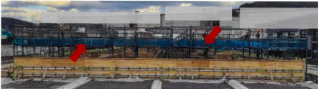
人の墜落対策を手摺と中棧、物の落下を防網を巾木型に取付けた地足場
