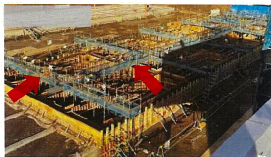
型枠組立時の防網使用地足場
