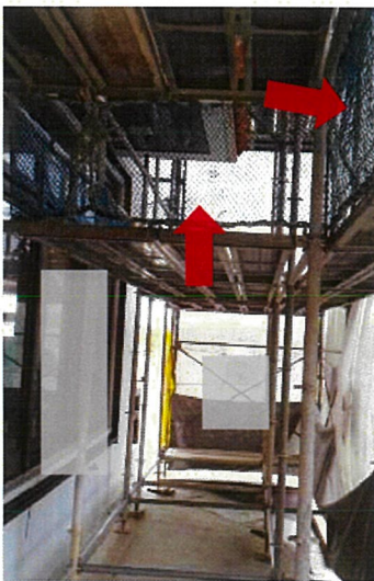
人の墜落対策を手摺と中棧、物の落下を防網を巾木型に取付けた地足場
