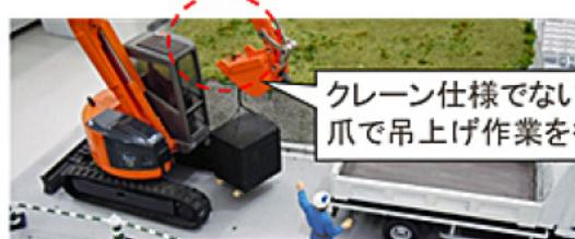
クレーン仕様でないBHでバケットの爪で吊上げ作業を行っている。
