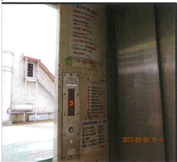
エレベーターの扉付近
