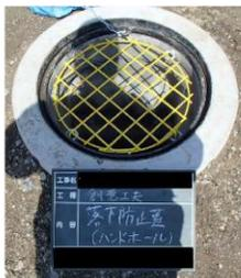
マンホールの蓋に、**落下防止網**を用いて**転落防止措置を実施**した。
