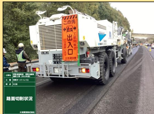
施工機械の直近で出入りを 周知する看板の設置
