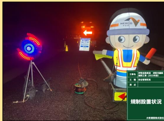
規制テープ一部にオリジナルバルーンの設定 車線規制材の視認性確保
