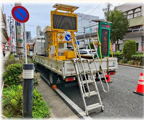
推奨される3点支持の手すり付き昇降設備の現場配置
