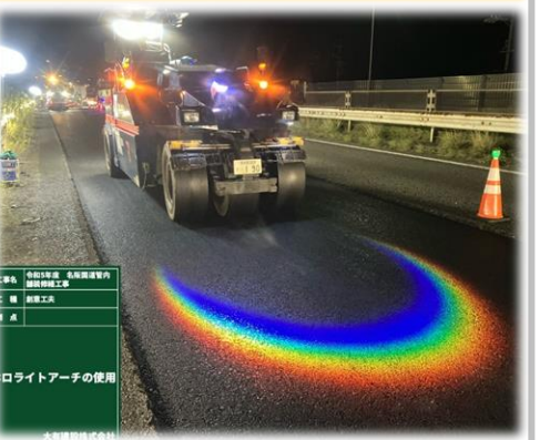
重機と人の分離を見える化し、夜間施工を逆手に取った安全管理
