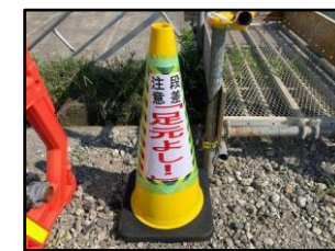
段差注意喚起 = 黄色
